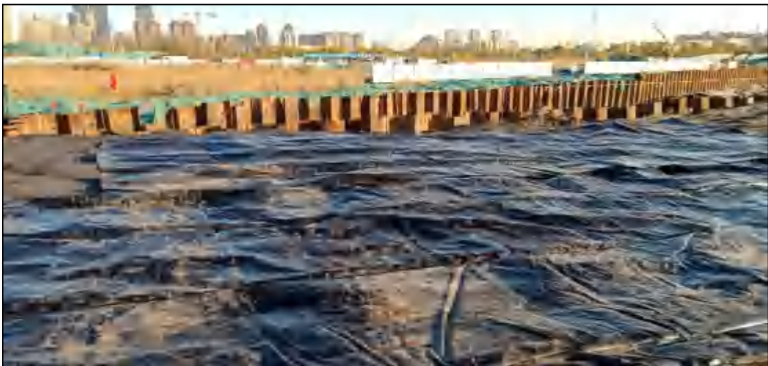
图 6-6 F15 地块修复区钢板桩
